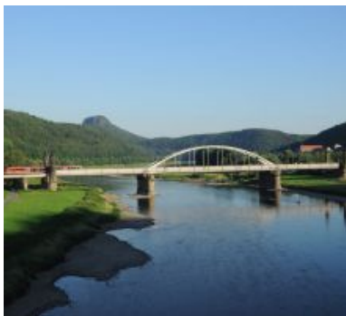
Quelle: Verkehrsverbund Oberelbe (VVO)
